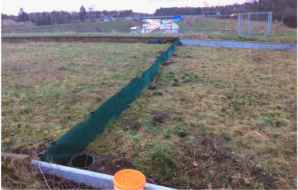
Abzäunung der Grünbrücke über die A33. Foto: F. Ahnfeldt. Fencing off the wildlife overpass over the motorway A33.
