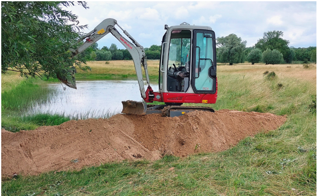
Lebensraumverbessernde Maßnahme am Gewässer 09 mit Anlage eines Sandwalls mit Sandentnahme vom nahe gelegenen Lippeufer. Foto: A. Greb. Habitat improvements at water body 09 with creation of a sand wall with sand removal from the nearby Lippe river bank.
