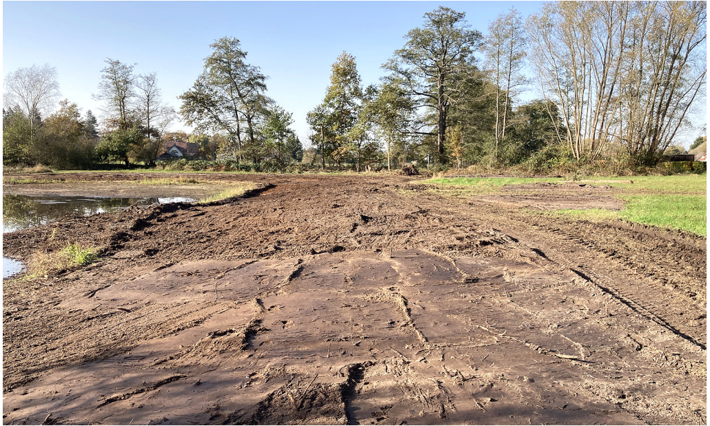
Kampeters Kolk nach den Rodungs- und Fräsarbeiten im Gewässerumfeld. Foto: F. Ahnfeldt. Kampeters Kolk after the clearing and milling work in the vicinity of the water body.
